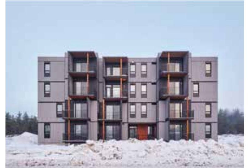
Les Pavillons Du 49
